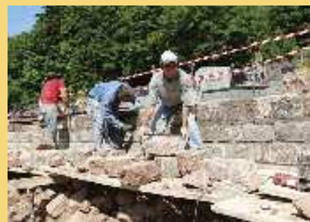
Le mur en pierres de taille du cimetière s'est éboulé côté route départementale. Quelques mois plus tard, les travaux de maçonnerie, effectués dans les règles de l'art, auront permis de consolider l'ensemble.
