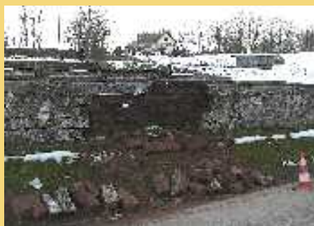
Le mur en pierres de taille du cimetière s'est éboulé côté route départementale. Quelques mois plus tard, les travaux de maçonnerie, effectués dans les règles de l'art, auront permis de consolider l'ensemble.
